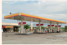
La stazione di servizio
